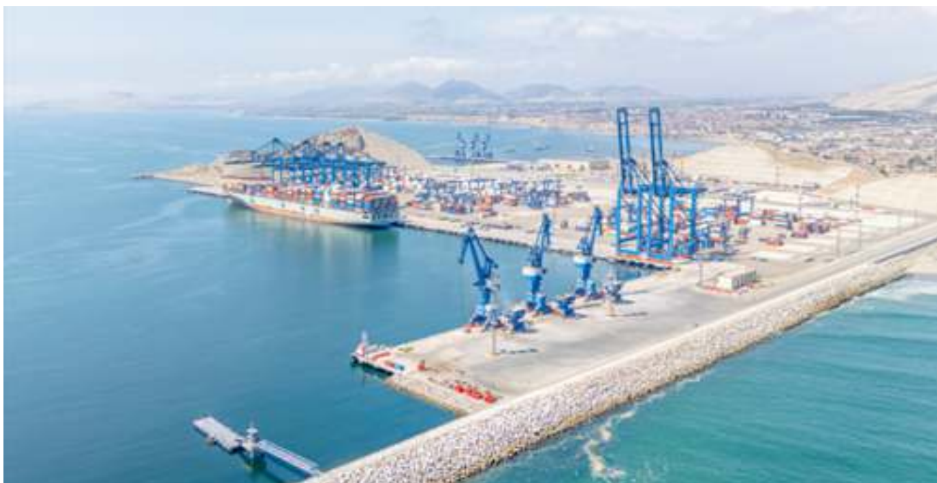
TP Multipropósito de Chancay
